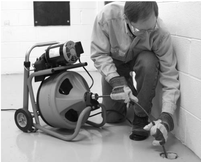
Figure 12 – En position de travail, avancement manuel du câble
